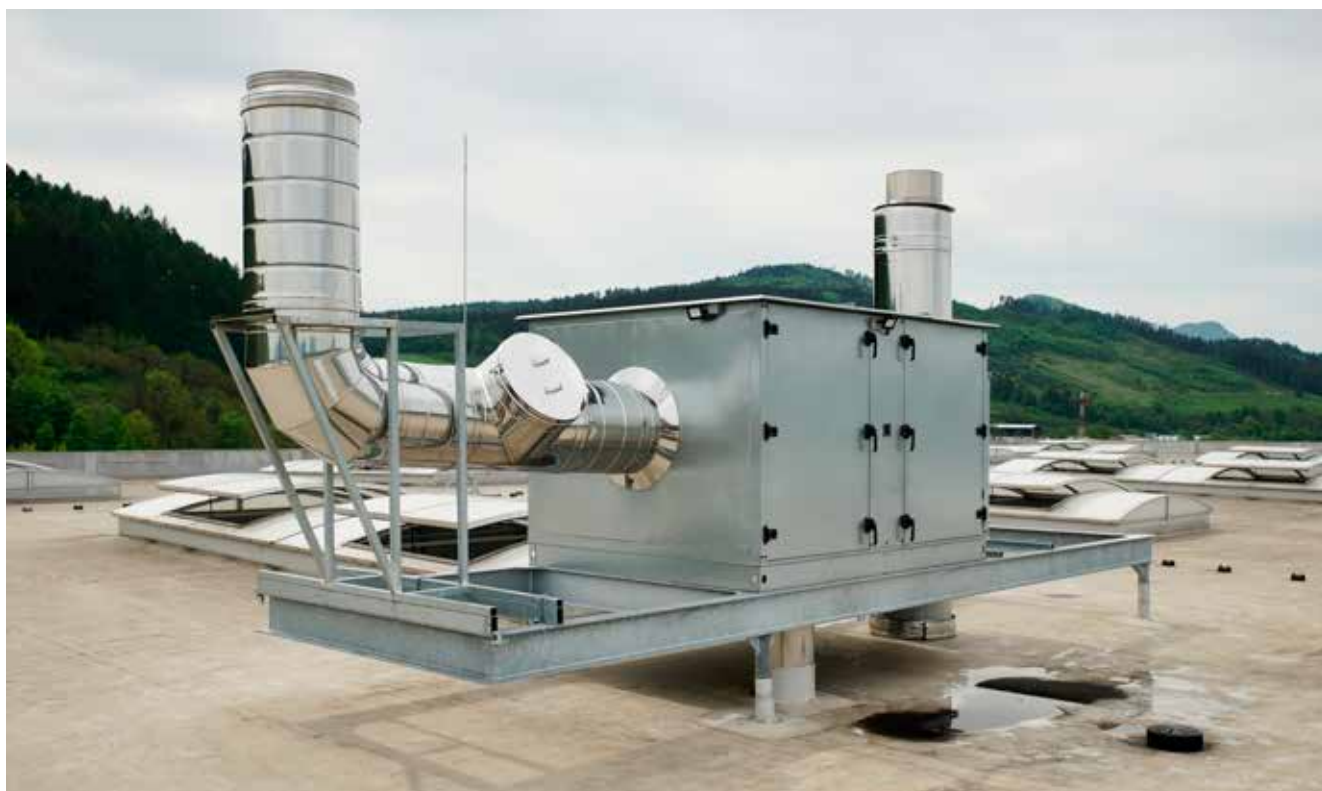
Instalace Heat Recovery Systému ve vnějším prostředí – Slovensko
