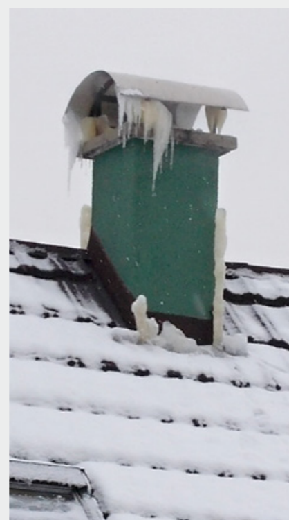
Obr. 3 Stříška Napoleon na kondenzačním kotli
