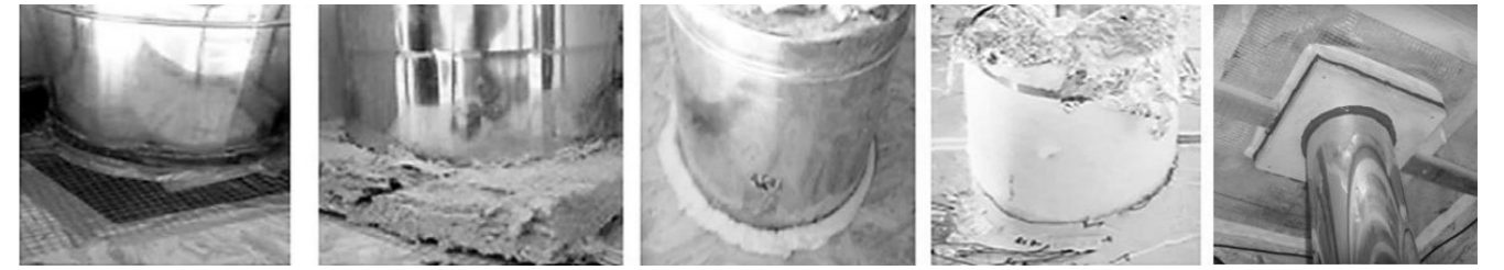
Obr. 2: ukázka řemeslného zpracování a utěsnění prostupu komínového tělesa střešní konstrukcí: a) vzduchotěsné utěsnění; b) utěsnění minerální vatou; c) vyplněn izolačním materiálem pro střechy; d) vyplněn PIR (2); e) průchod střechou za použití izolační průchodky
