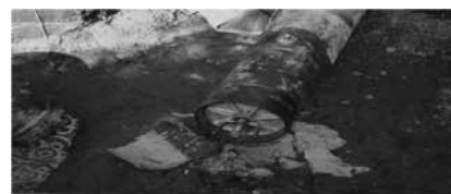
Obr. 1 Místo, kde byla zátka instalována
