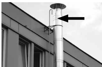
Obr.č.1 Provedené vyústění odfukového potrubí
