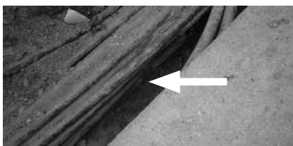
Obr.č.5 Příklad souběhu plynového potrubí se 14 kabely
