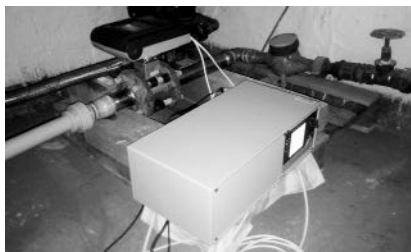
Obrázek 1 – Průtokoměr OPTIFLUX 1000 osazený za vodoměrem s měřicí ústřednou AHLBORN ALMEMO A 5690-2 TS v bytovém domě v Českém Těšíně
