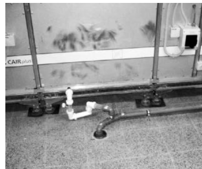
Obr. 7 Ukázka řešení vodní uzávěrky bez vizuální kontroly a možnosti servisu (vlevo) a s možností kontroly vodní hladiny a doplňováním vody (vpravo).
